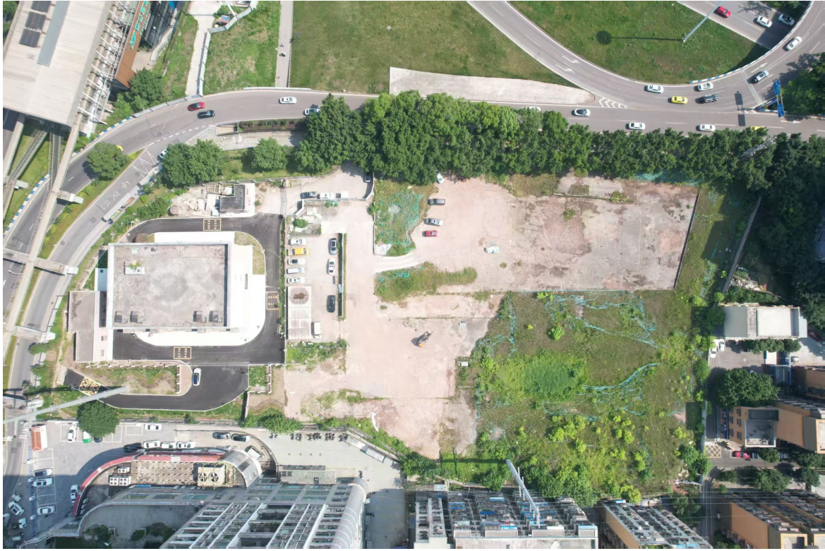
图 2.4-1 项目开工前航拍影像
