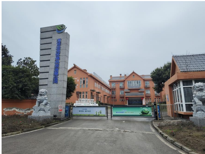
图 2.4-2 弃渣场大门现状
